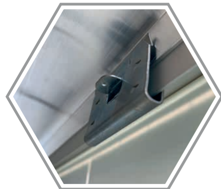
Morsetto a molla in acciaio
